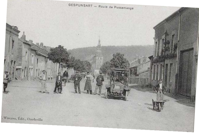
Route de Pussemange : Point de bolides à faire ralentir à cette époque...
